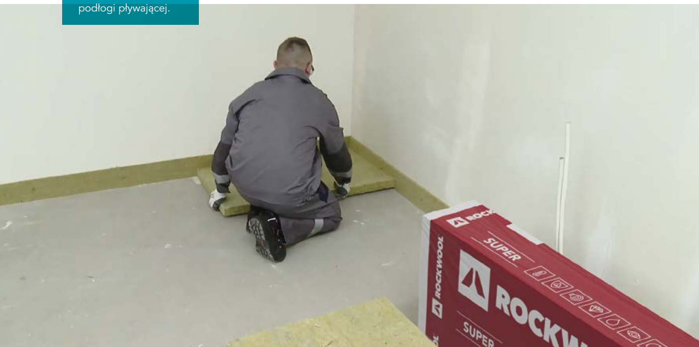
Ułożenie izolacji podłogi pływającej.
