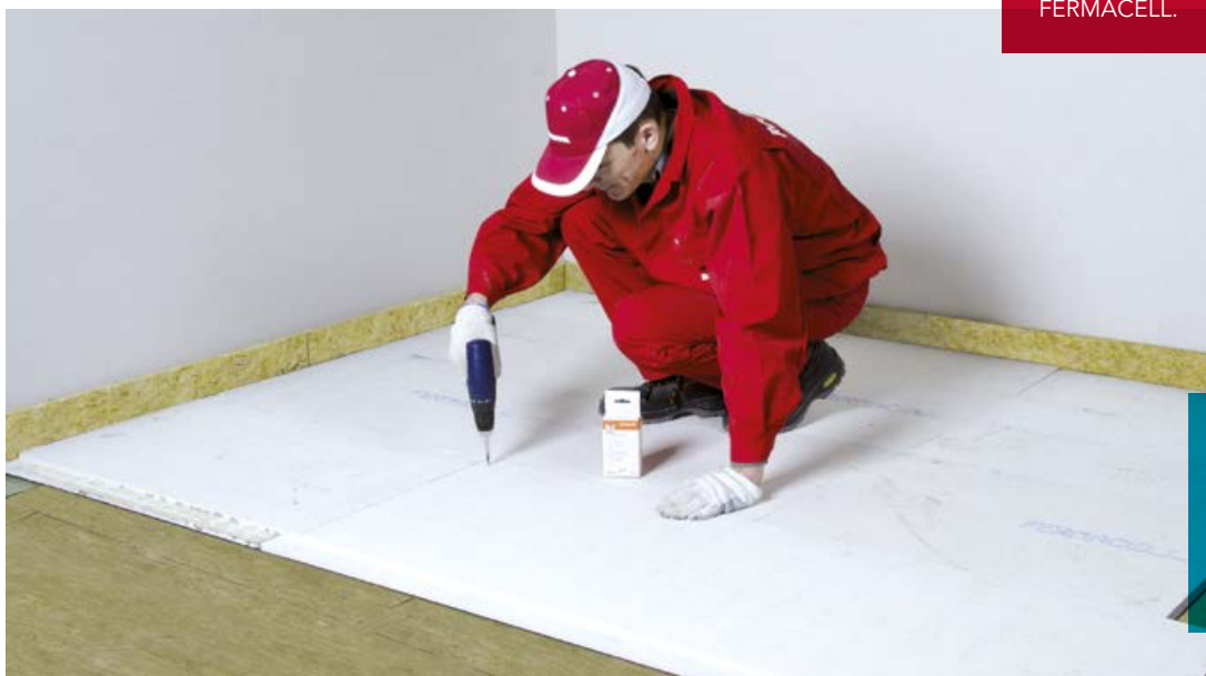
Przykładowe rozmieszczenie łączników dla płyt FERMACELL 2E22
