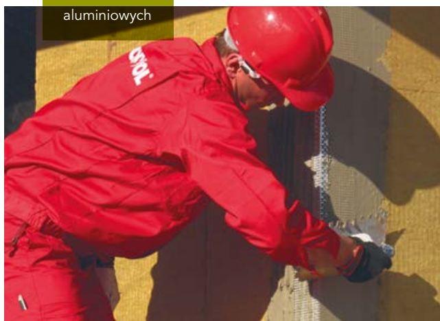
Montaż narożników aluminiowych
