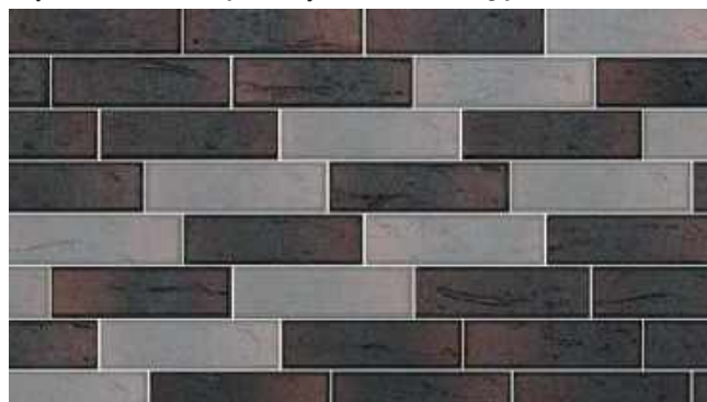
Wiązanie wozówkowe – przesunięcie ukośne o 1/4 cegły
